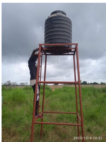
Wateropslag in aanleg
