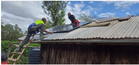
Montage zonnepaneel
